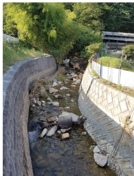
災害後の流失状況：アシ原が完全に消失
