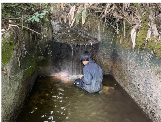
コンクリート水路となった環境
